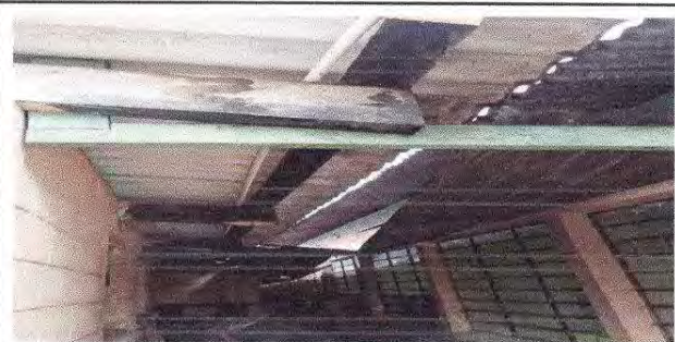
Foto 5: sustitución de canales de metal.
