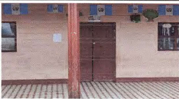
Foto 3: sustitución de puerta
