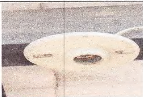
Foto 8: sustitución de plafoneras
