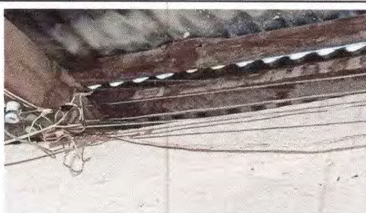
Foto 12: Sustitución de cableado eléctrico
