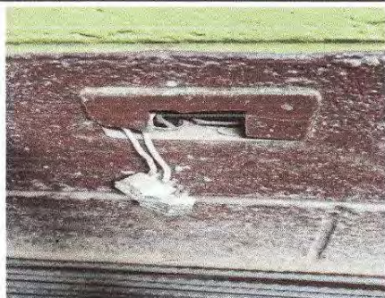
Foto 11: sustitución de tomacorrientes dobles
