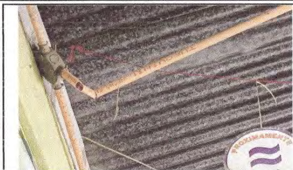
Foto 13: Sustitución de ducto eléctrico y accesorios
